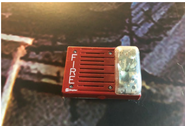
F1 - Cloudy Fire Alarm Device
